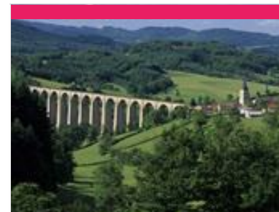
Viaduc de Mussy-sous-Dun
